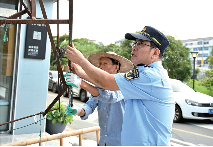
蒋森波在拆除广告架。
