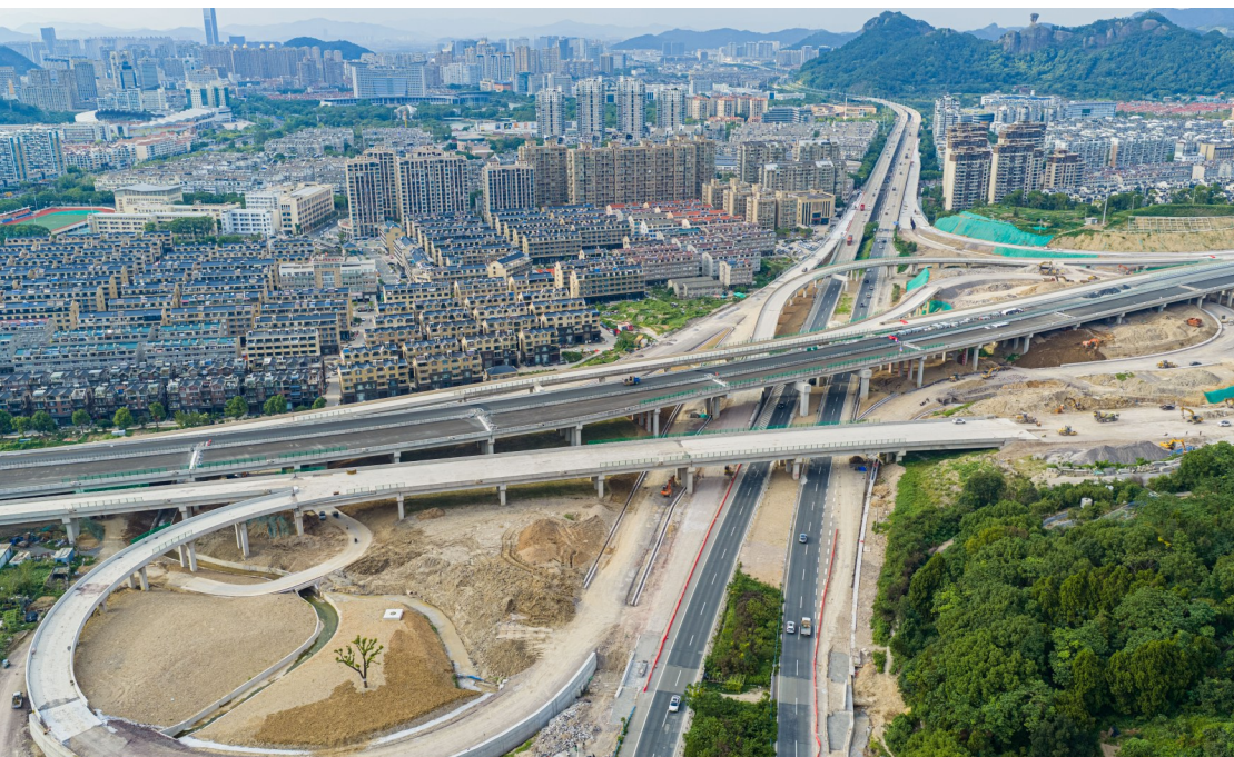
太平街道南环互通匝道施工现场。
