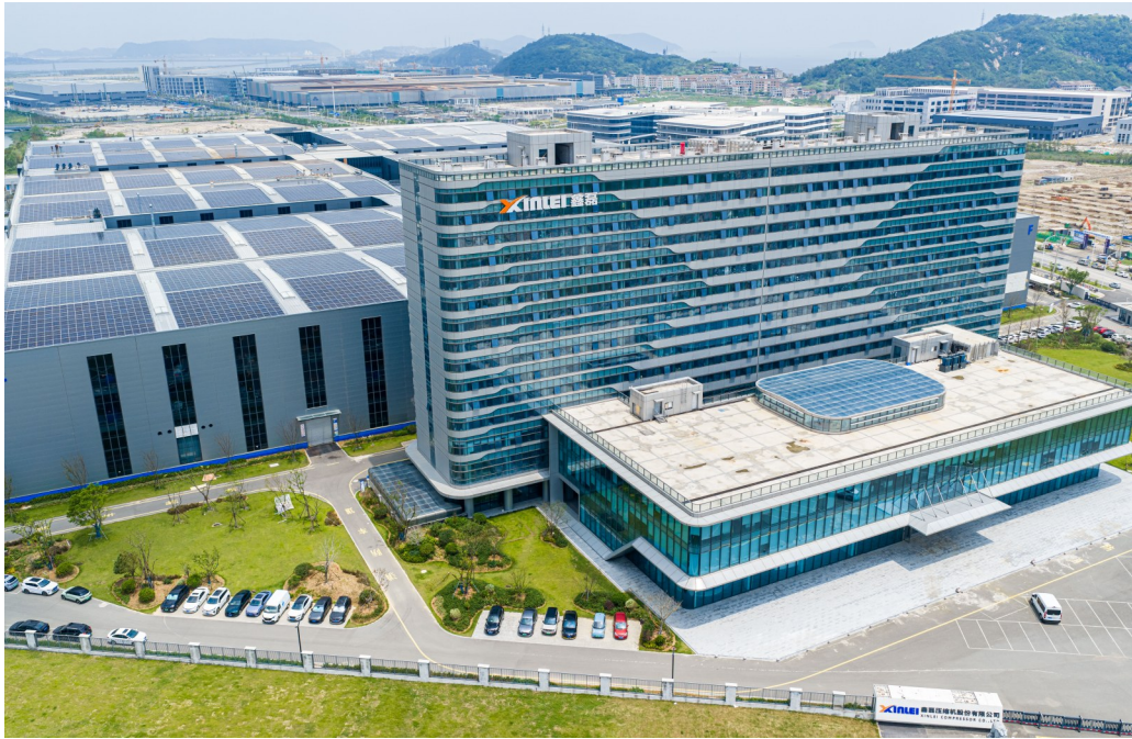
温岭经开区一家企业的屋顶上，光伏板沐光发电，源源不断输送清洁能源。记者 徐伟杰 摄
