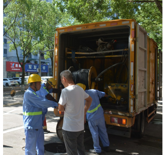
养护工人疏通地下管道。
