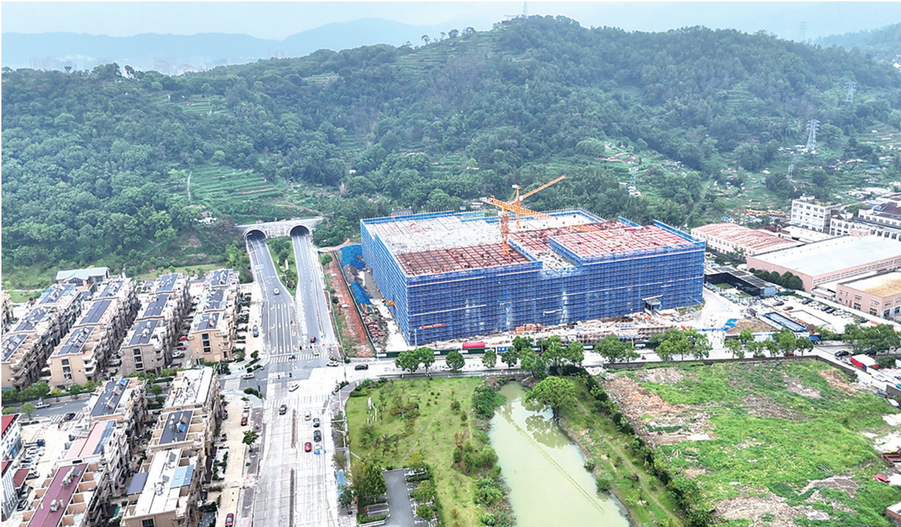
上林工业园区施工现场。
