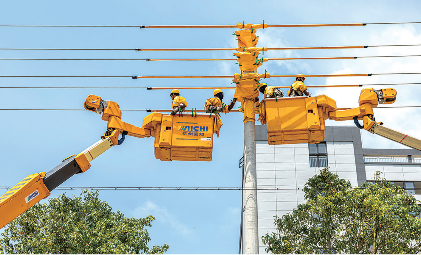
电力工作人员开展高空作业。
