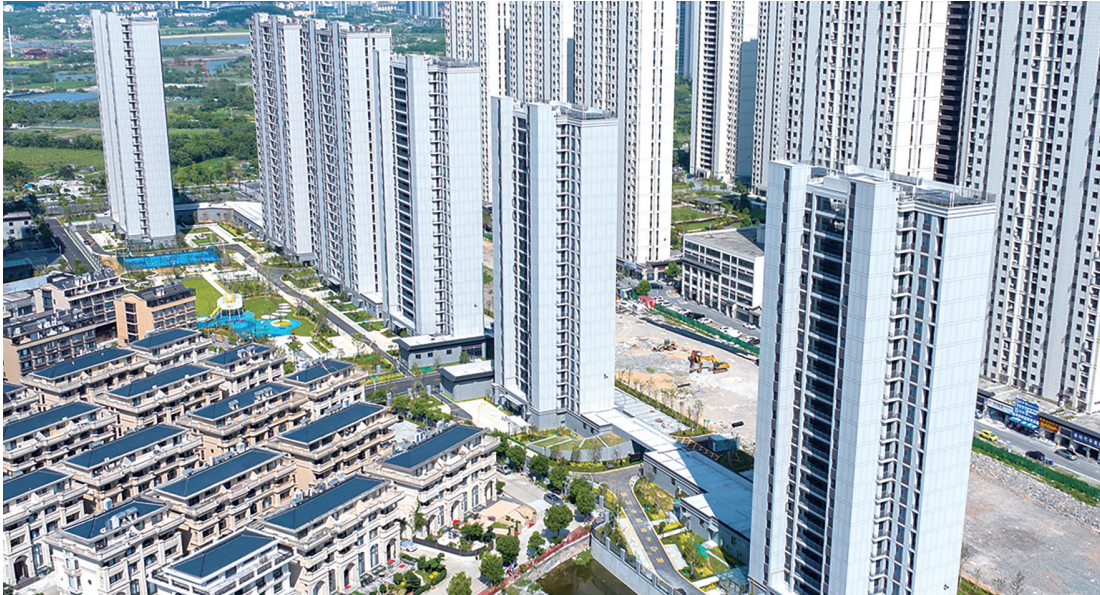
项目现场，崭新的高楼整齐排列。
