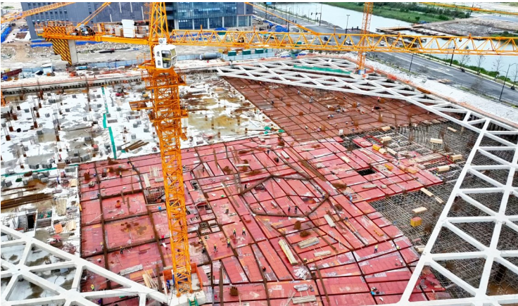
环龙门湖科创带创新转化服务中心项目火热复工。
