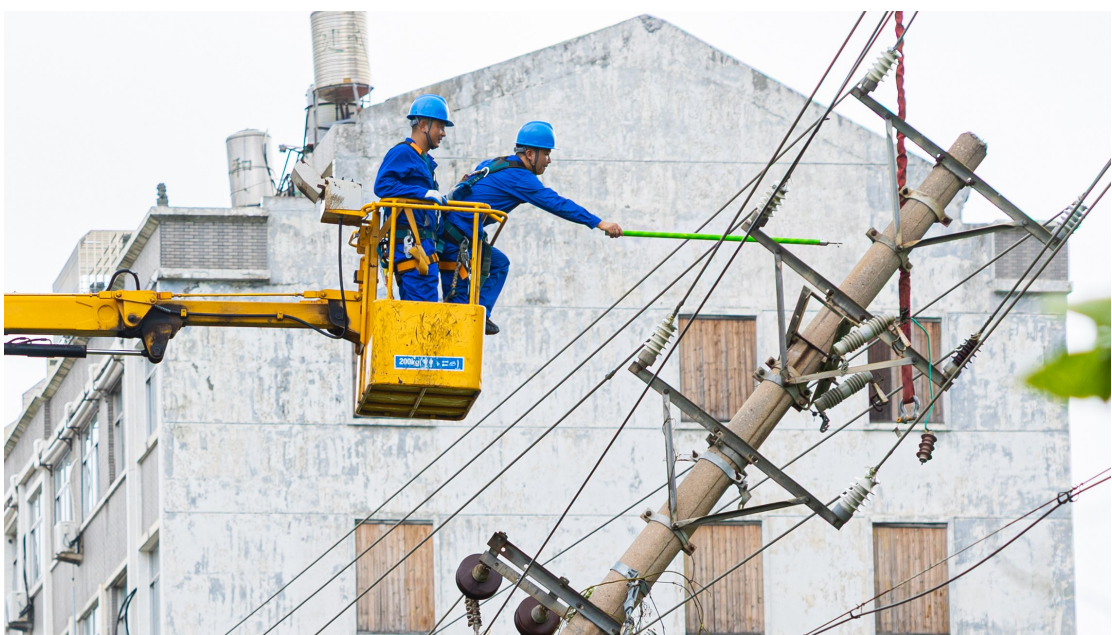
电力工作人员在松门镇松寨村，紧急抢修断裂电杆。记者 徐伟杰 摄
