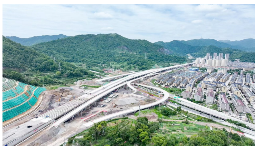
南环高架施工现场。
