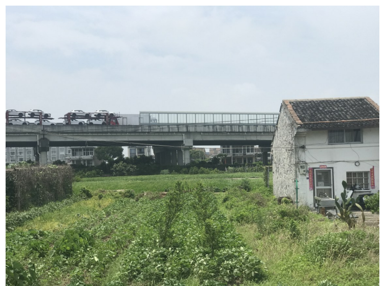
甬莞高速公路经过五房村
