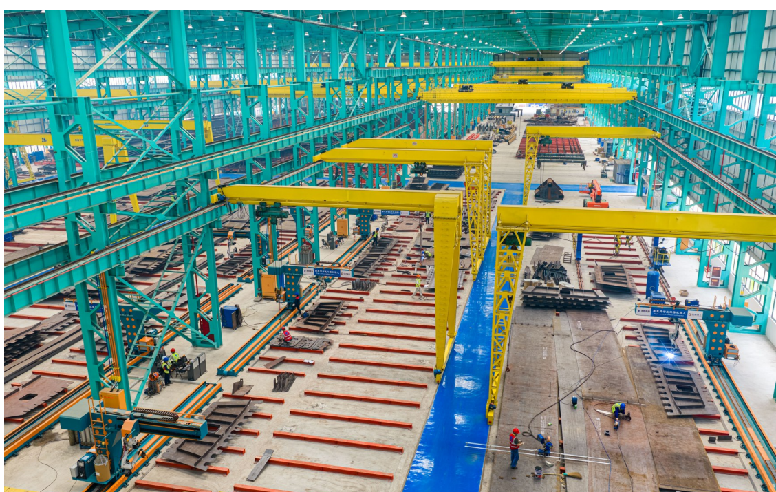
浙江金港重工科技有限公司建设现场。
