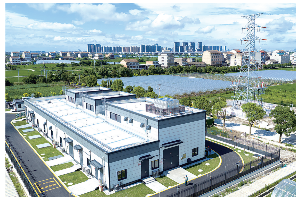
高龙110千伏变电站。
