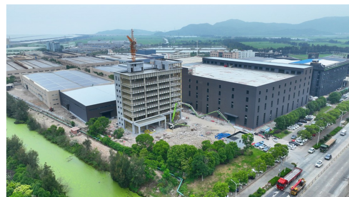
东部数控新建厂区。
