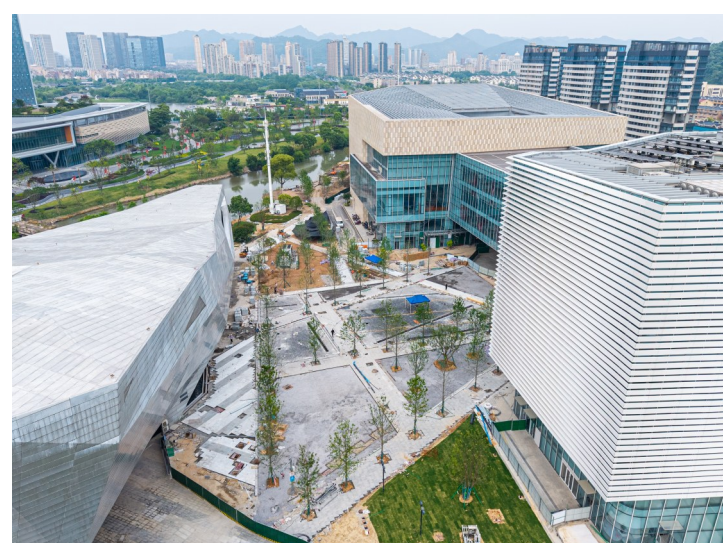
施工已进入收尾阶段。
