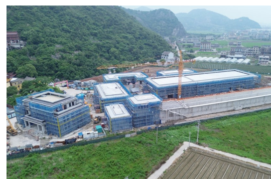
箬横水厂迁扩建项目正加速推进。
