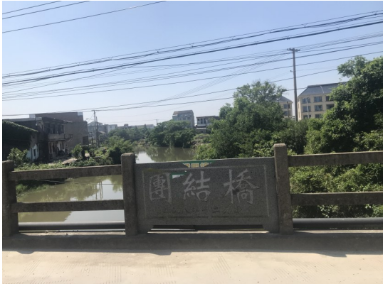
团结桥，南边为五房桥
