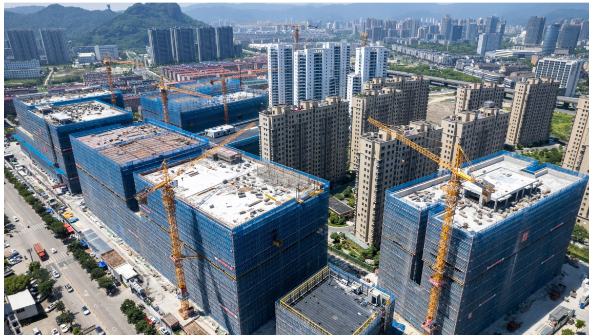
新城智谷二期项目施工现场。
