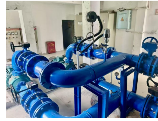
PE管更换成坚固的钢管。（图片均由石塘镇提供）
