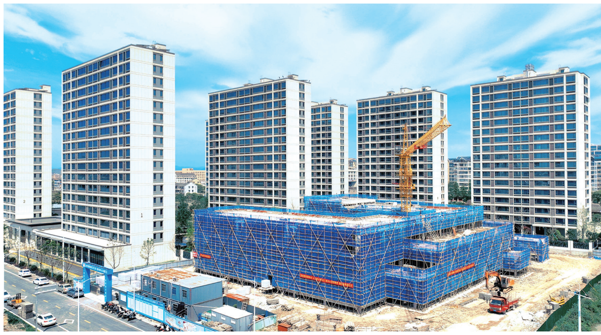
滨海中心幼儿园项目施工现场。
