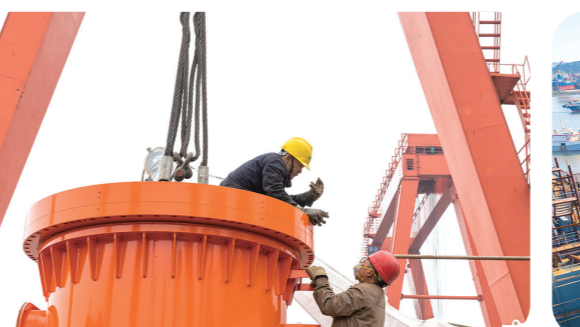
2026年4月中旬:重器精装。主推进器液压臂吊装到位。
