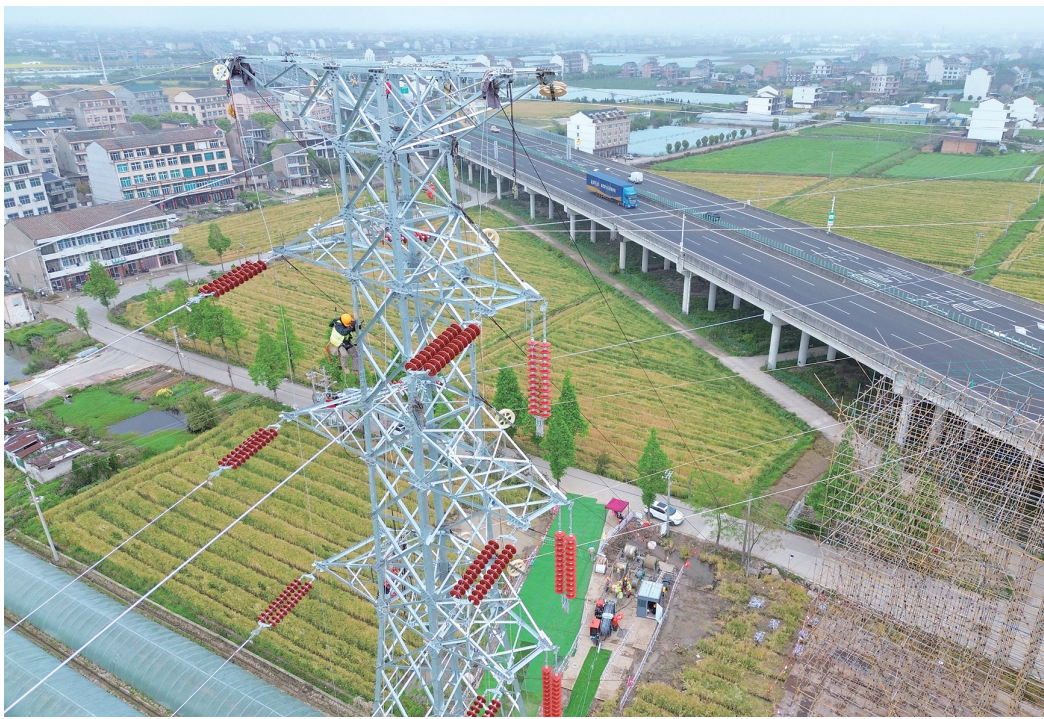
电力工作人员正在高空中作业。
