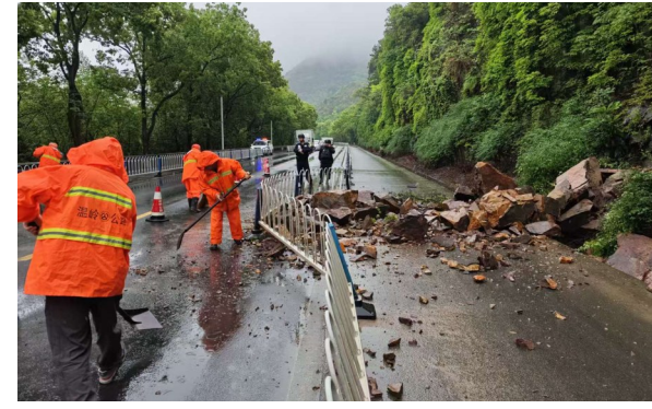
养护人员清理边坡塌方路段泥土。
