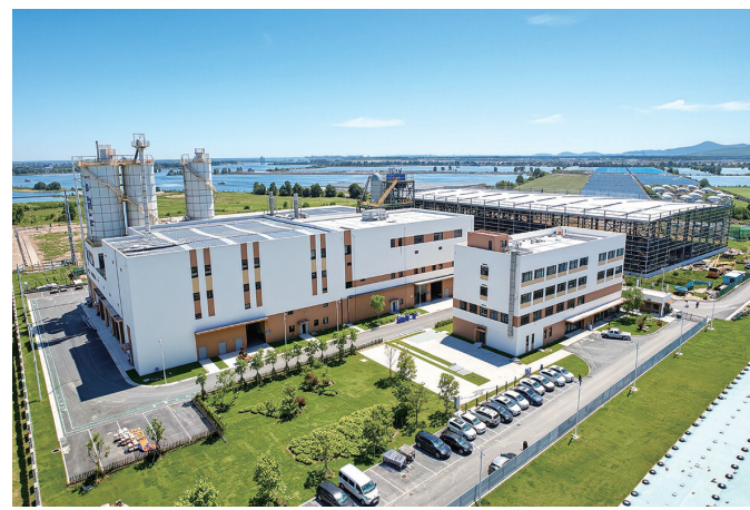
飞灰无害化资源化处置项目。
