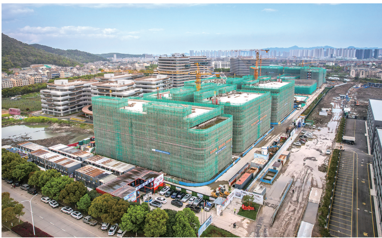
项目施工现场。
