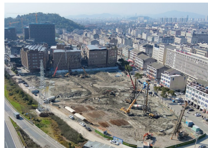
城北街道山洋地块高端童鞋智造园区项目施工现场。 通讯员 梁伟伟 摄
