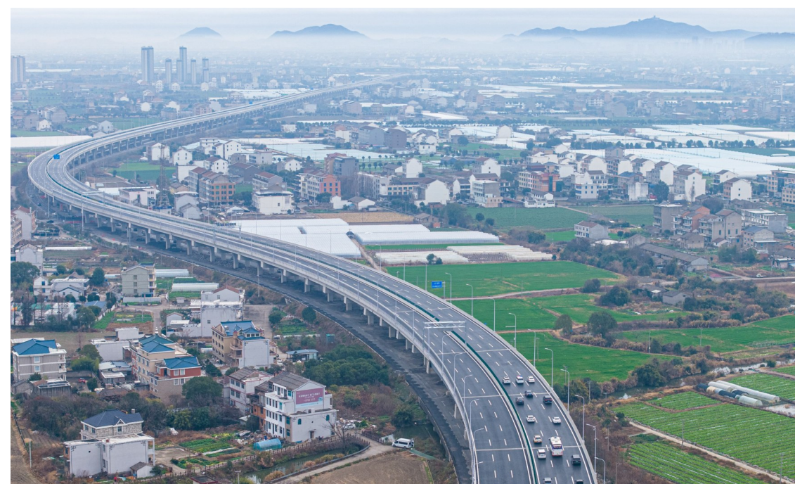
2月10日上午10时，太龙快速路正式通车。（无人机照片）
