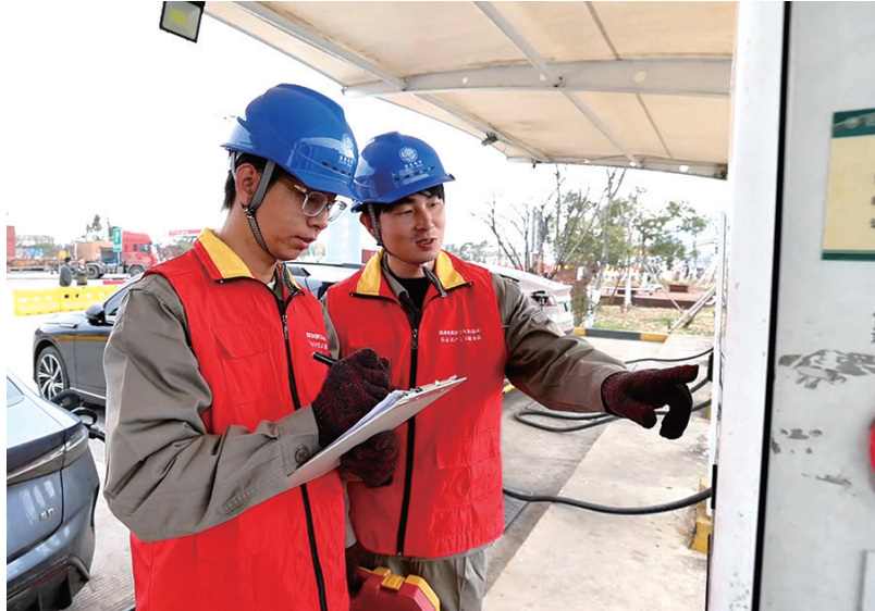
国网温岭市供电公司工作人员正在检查设备。
