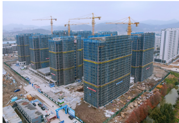
城南镇吉捕岙等三村公寓式安置房项目。
