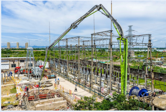
国网温岭市供电公司110千伏松门变开展升级改造,提升区域供电可靠性。
