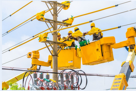
国网温岭市供电公司开展不停电作业,护航迎峰度夏。
