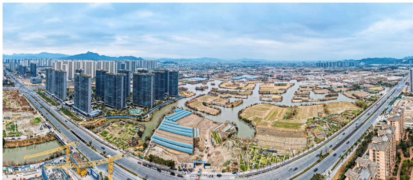
横湖路（中心大道—宗文路）市政工程施工现场。
