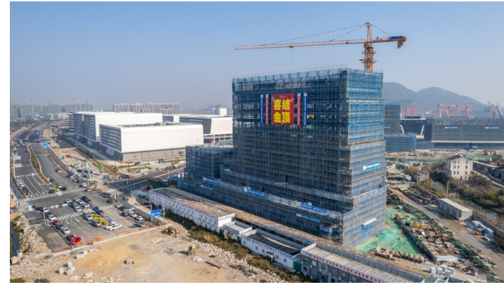
礁山渔港小镇核心区改造项目二期工程封顶。
