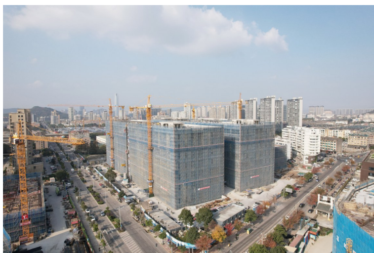
新城智谷项目施工现场。
