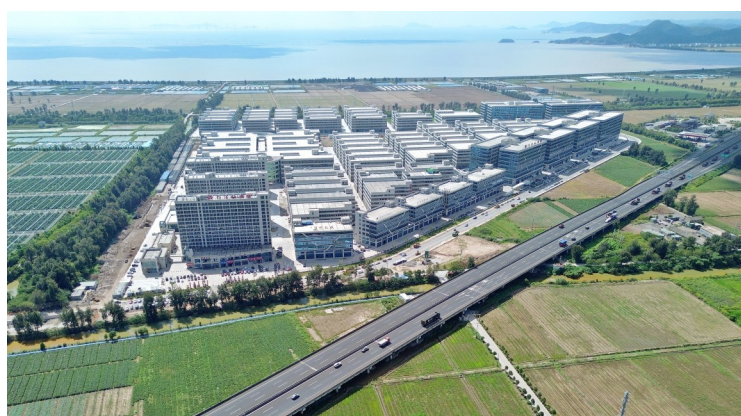
东浦泵与机电智造园（温岭万洋众创城）航拍图。
