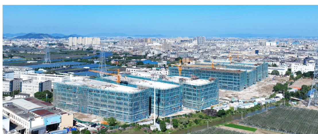
未来工业港智造园区项目一期施工现场。
