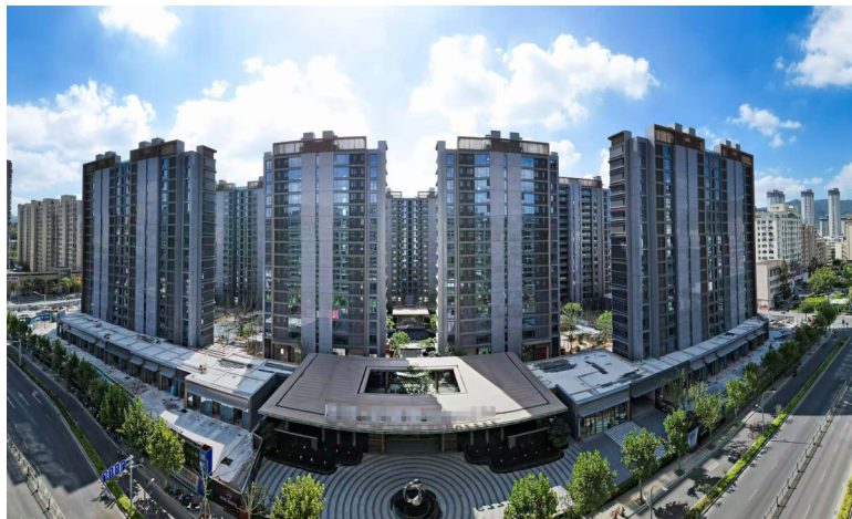
建设中的东门路区块住宅项目。
