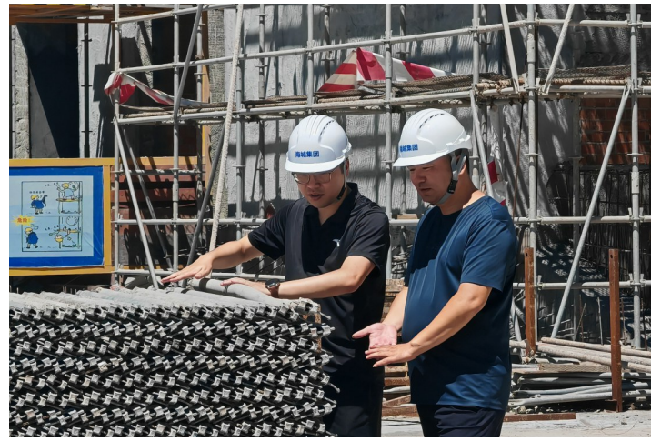
邵世杰（左一）在工地进行安全检查。
