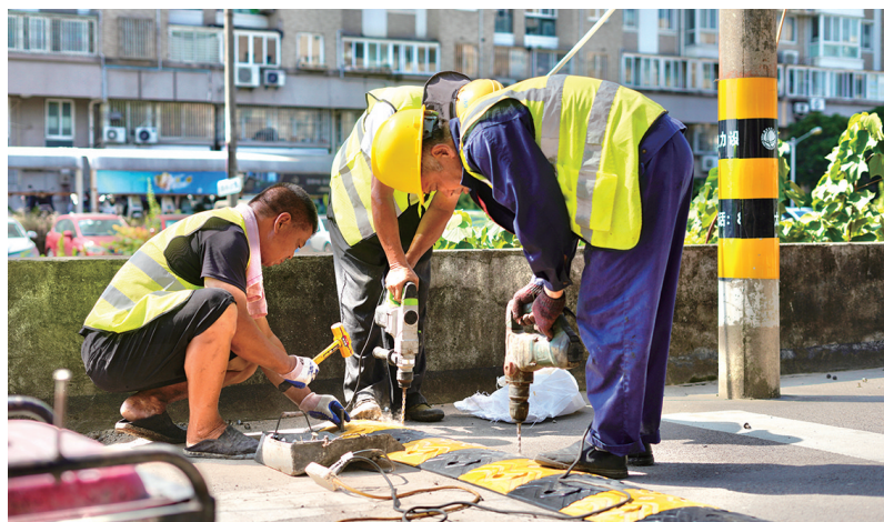
维修人员正在铺设新的减速带。
