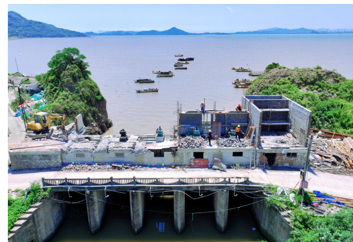
工人们正在管理房二楼主体的施工现场加紧作业。
