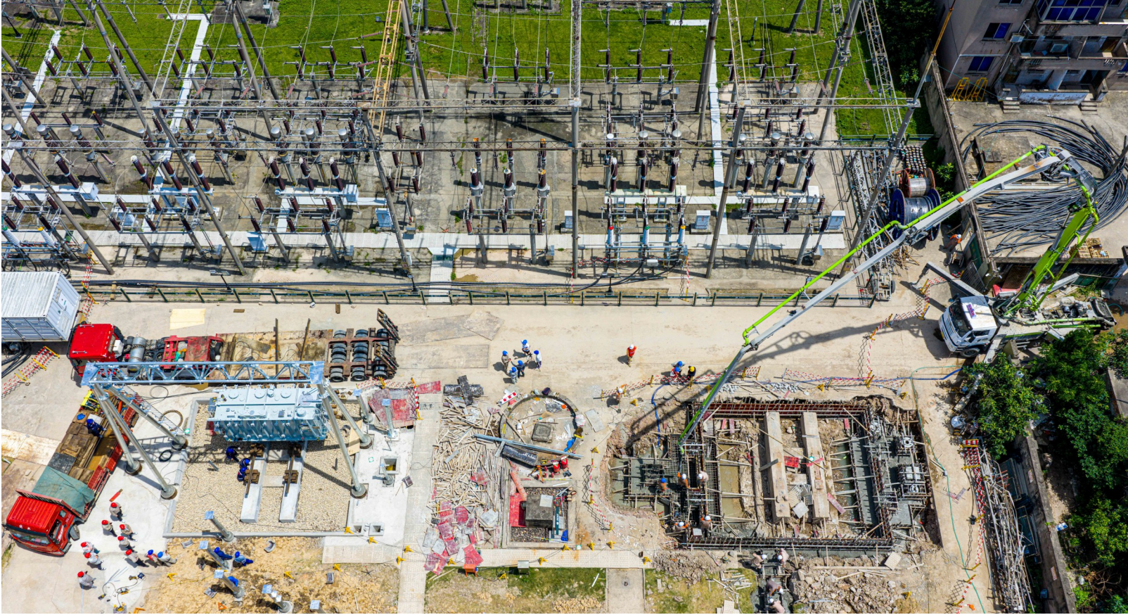
松门变电站2台主变更新现场。
