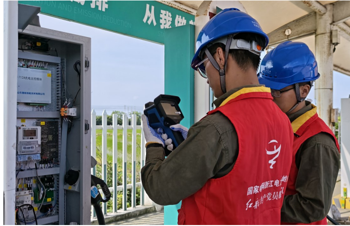
国网温岭供电公司工作人员正在检查充电设施。
