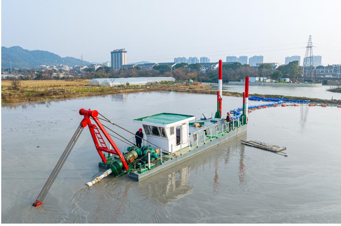
2月24日，在城北街道新开河内，清淤船上的工作人员正熟练地操作设备，将河底的淤泥吸入船舱，并通过管道输送到指定的堆放场地。
