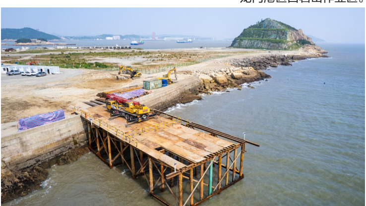
引桥灌注桩平台搭建。记者 章毅 通讯员 孙宗行 摄
