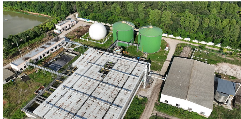
大型沼气综合利用工程助推资源循环利用。
