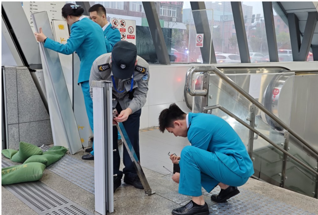
工作人员在站台出入口设置挡水板。
