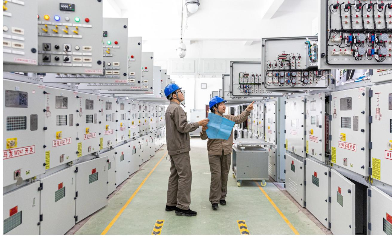
5月24日，在城西街道110千伏马公变内，国网温岭市供电公司工作人员正在对配电装置及监控系统进行改造升级，以进一步提高电网运行的安全性和可靠性，为迎峰度夏期间居民和企业用户的用电无忧打下坚实基础。
