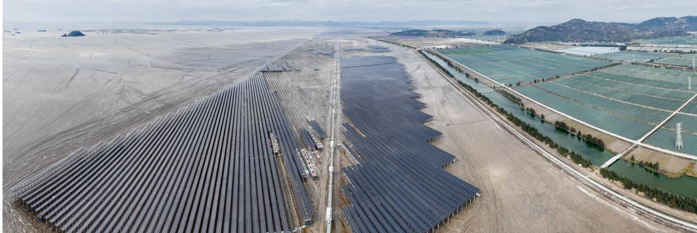
2月5日，南海涂渔光互补光伏电站项目一期工程在松门镇正式并网发电。一期年发电量约2.57亿度并全额上网消纳，可满足7.5万户常规居民一年的用电需求。
