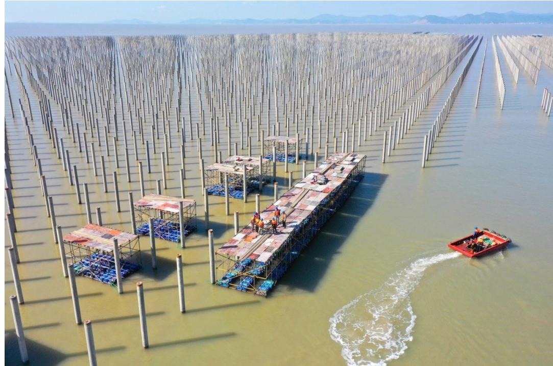
10月29日，市东部松门渔光互补光伏电站项目建设现场，建设者正在安装太阳能板作业平台。
