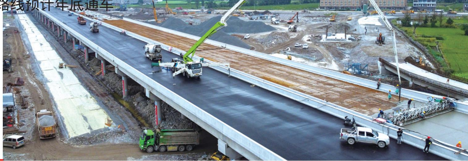
10月9日,在甬台温高速至沿海高速温岭联络线工程项目新河段施工现场,工人们正有序进行水泥路面浇筑。
