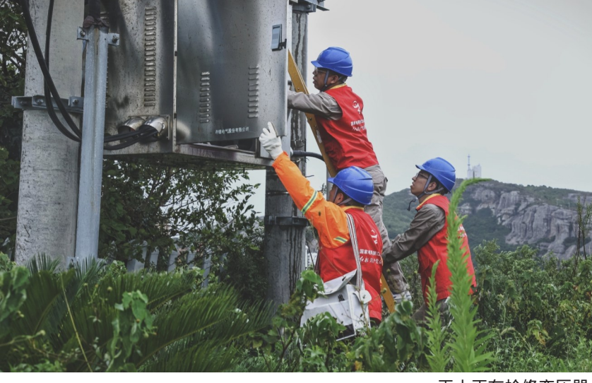
工人正在检修变压器。
